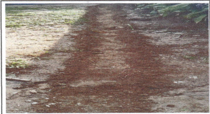
Foto 10: Sustitución de tubería PVC, línea principal de aguas negras
