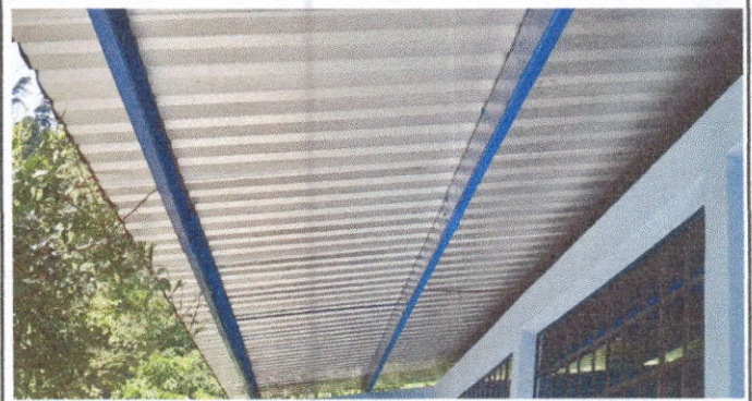
Foto 8: Mantenimiento a soporte de estructura de metal.
