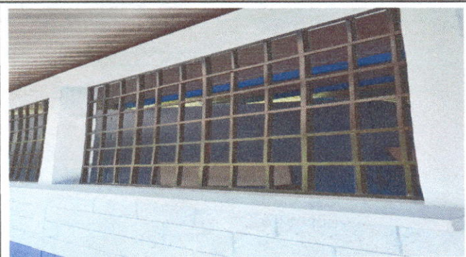
Foto 3: Mantenimiento de estructura de metal ventanas.
