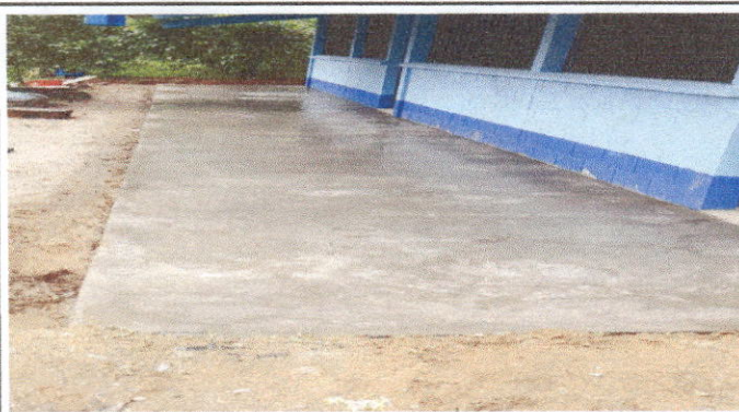
Foto 9: Reparación de piso de torta de concreto
