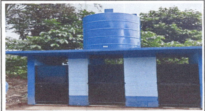
Foto 4: Sustitución de deposito de agua 1100 lt
