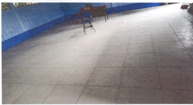
Foto7: Sustitución de piso torta por ceramico.
