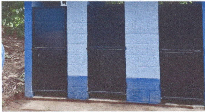
Foto 1: Mantenimiento a estructura puertas (lijado, cambio de tubo, cepillado, sujeciones, aplicación de pintura)
